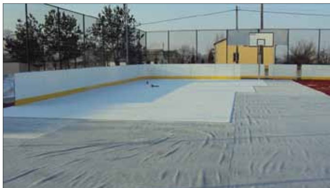
Lodowisko syntetyczne w trakcie montażu na Orliku – panele typu L – idealnie równa powierzchnia
