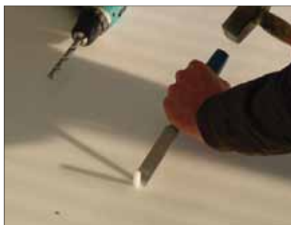
Usuwanie wystającej części kołka
