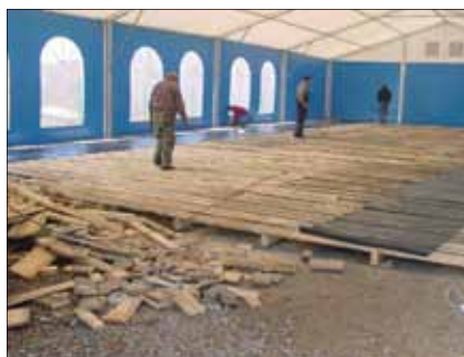
Wyrównianie nawierzchni za pomocą podestu z desek oraz pokrycie go folią
