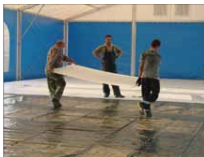
Montaż paneli AMARGiCE®
