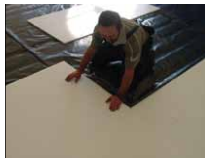
Panele typu L o prostych krawędziach łączone są na pióro/wpust
