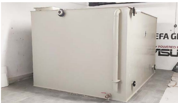
Zbiornik przeciwpożarowy 18 m 3 dla budynku biurowego
